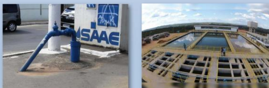
Figura 4: Poço artesiano público localizado na região central do município, gerenciado pelo SAAE (Fonte: SAAE). Figura 5: Estação de Tratamento de Água (Ascom PHSL)
