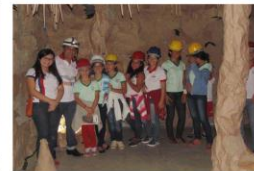
Figura 5: Construção de caverna artificial em Paripiranga (BA)
